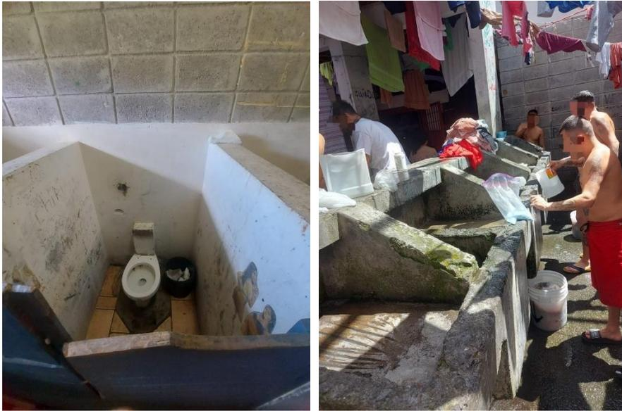
**Fotos:** Módulo A. Izquierda, sanitario sin agua y sin que funcione la cadena, con paredes y piso en mal estado. Derecha, personas bañándose en el área de pilas, con exposición a la mirada general y en pocas condiciones higiénicas.
